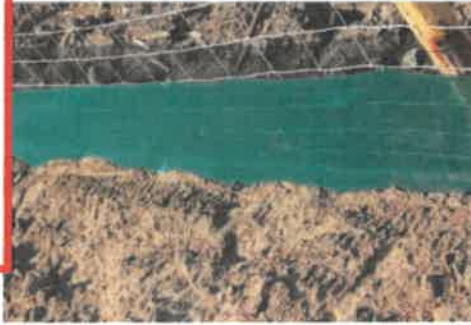
Figure 2 : Filet enterré posé sur un grillage grande faune (Source : THEMA-Environnement)
