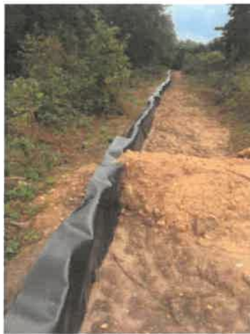
Figure 4 : bêche enterrée avec bavolet et trampoline (Source : EcoSphère)
